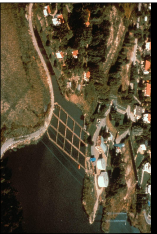
Ferric Chloride Treatment Unit at Lake Ronningsesjon, Tabby Sweden (Karl Dunker)
